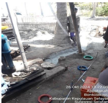
Gambar 4. Pemasangan Elektroda 4 buah
