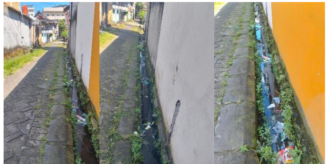
Gambar 3. Kondisi Eksisting Drainase Sumber: dokumentasi lapangan
