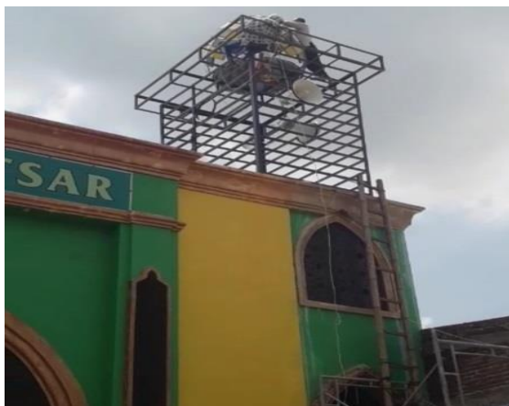
Gambar. 4 Pemasangan atap dan ACP serta atap menara
