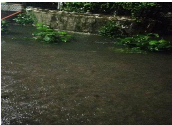
Gambar 3 Sistem drainase yang buruk
